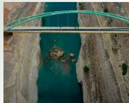
Á meðfylgjandi mynd, sem tekin var 1. júní 2021 sést hvar skriða hafði fallið niður í skurðinn vegna skemmda á steinsúlum sem styðja bakkana. Skurðurinn var lokaður í nokkra mánuði meðan rannsókn og viðgerð fór fram.
