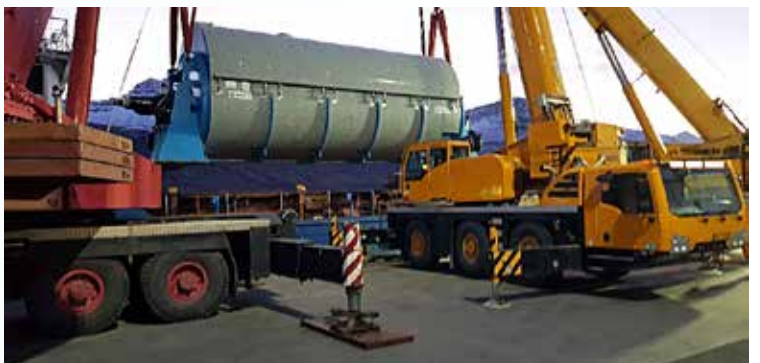
Nýr gufuburrkari hífður í land á Fáskrúðsfirði. Burrkarinn er 115 tonn. Nú í desember kemur þriðji þurrkarinn og er þá á sjö árum buið að endurnýja allan þurrkarakost fiskimjölsverksmiðjunnar.
