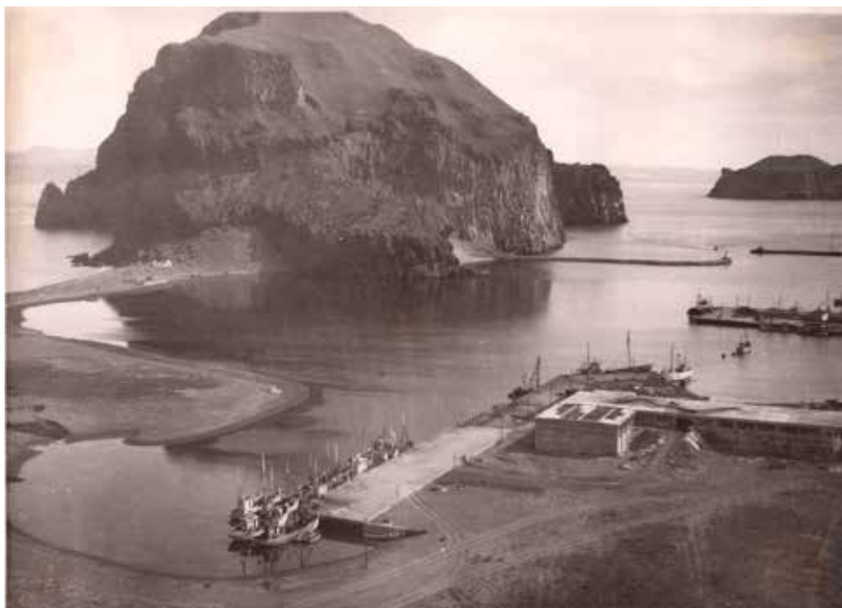
Höfnin í Vestmannaeyjum, Friðarhafnarbryggja. Vinnslustöðin hf í byggingu og Heimaklettur í baksýn. Ljósmynd: Ólafur Magnússon.
