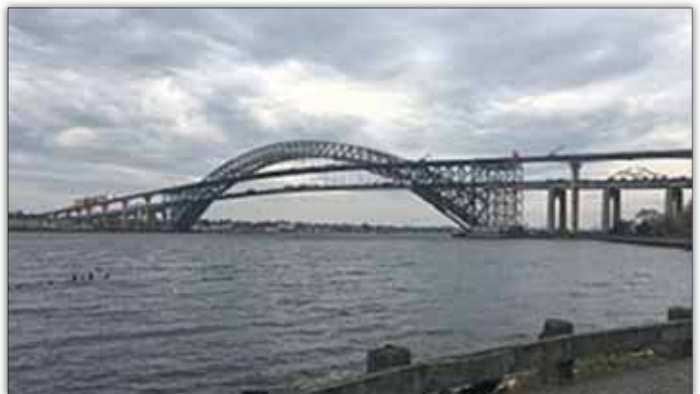
Bayonne brúin með nýja brúardeckinu og 19.5 m lægri gamla deckinu, sem var svo fjarlægð.
